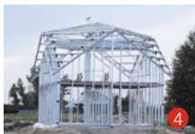
4. Заключительные этапы сборки каркаса
