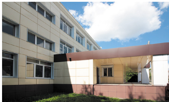
Вентилируемый фасад комбинированного типа (металлокассеты и керамогранит) для учебного заведения.
