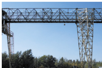
1. Приемка металла (склад металлопродукции)
