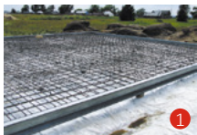
4. Заключительные этапы сборки каркаса
